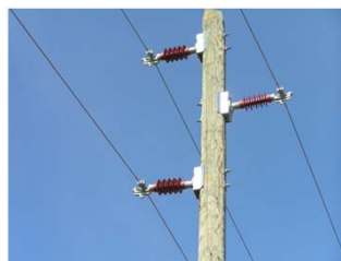
Slika 2. Kompozitni EVA izolatori za horizontalnu montažu na drvenom stupu
